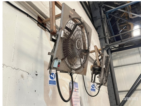
รูปที่ 3-19 พัดลมระบายอากาศในพื้นที่ทำงาน
