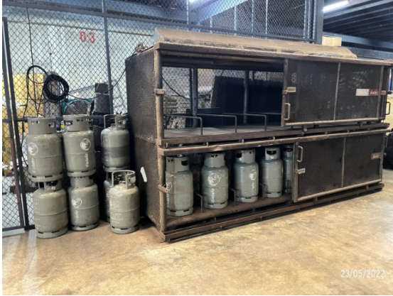
รูปที่ 3-16 พื้นที่จัดเก็บถังเก็บแก๊สสำหรับ รถโฟล์คลิฟต์
